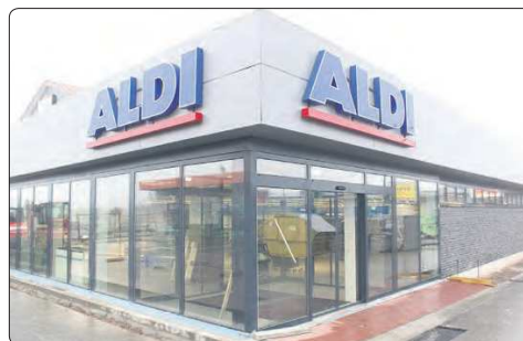
Der neue, moderne ALDI-Markt in Meerane. Noch bis kurz vor der Eröffnung wurde gebaut. Foto: Uwe Wolf
